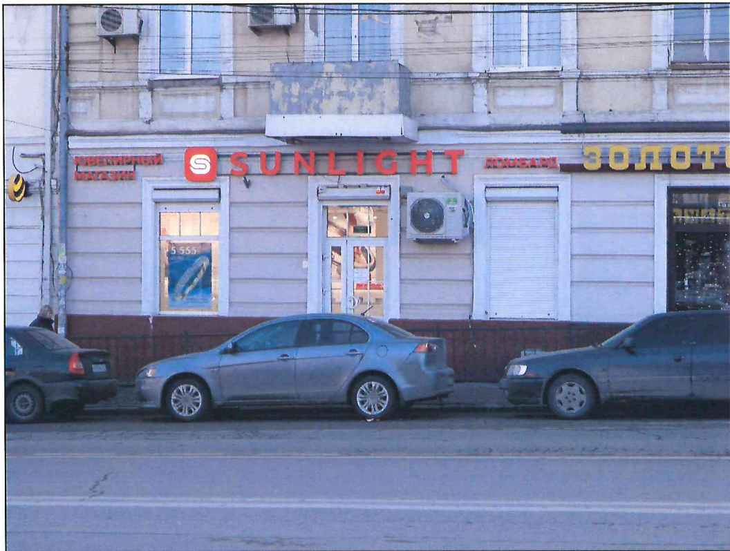
4. Фрагмент парадного восточного фасада в уровне первого этажа. Фото 2024 года.
