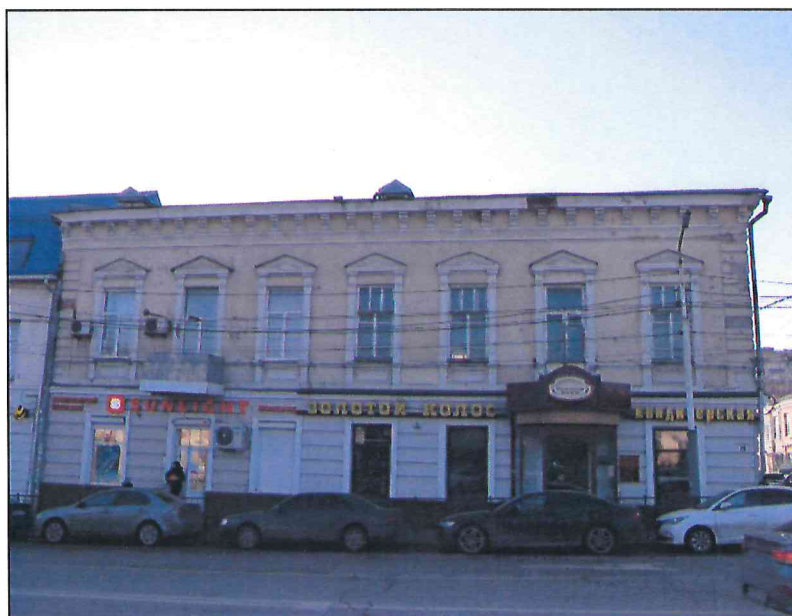
2. Парадный восточный фасад Объекта. Фото 2024 г.
