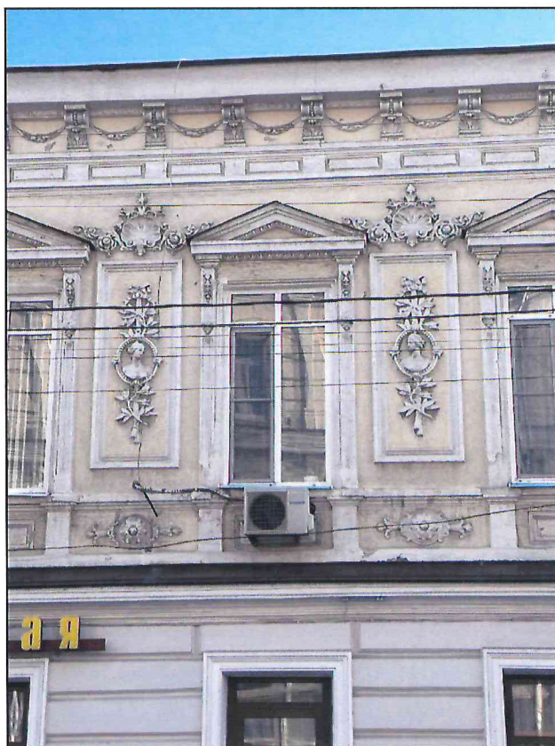
7. Фрагмент парадного северного фасада Объекта в уровне второго этажа. Фото 2024 года.
